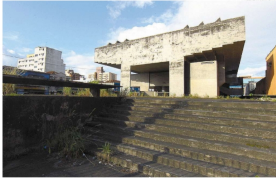
Antigo colégio, na Vila Nova, está deteriorado; Prefeitura irá estudar o que fazer com o imóvel
