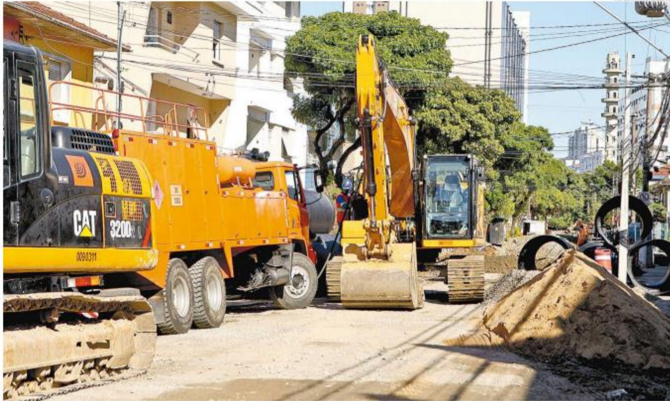
Neste momento, pelo menos 170 trabalhadores estão engajados nos trabalhos da segunda fase do VLT, entre o pessoal que está atuando nas ruas e as equipes de escritório
