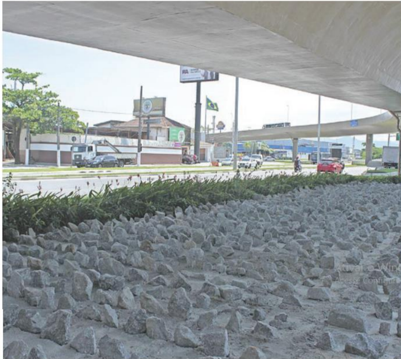
Sob o viaduto de entrada de Santos, Prefeitura colocou pedras para evitar a ocupação; Administração nega objetivo da iniciativa
