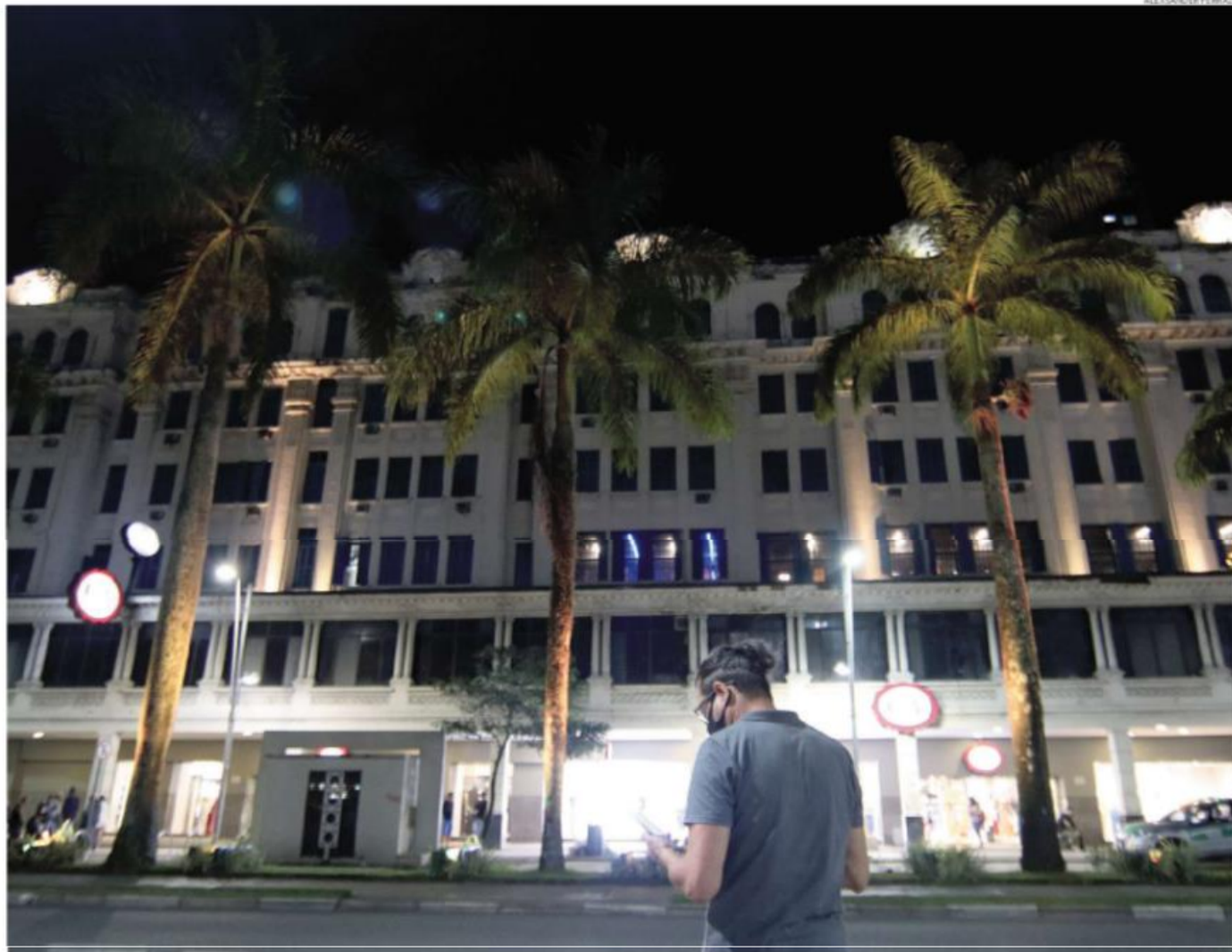
Um exemplo de ação bem sucedida de Santos envolvendo a iluminação pública é a revitalização de trecho da Avenida Ana Costa, que não tem mais cabos de energia elétrica expostos
