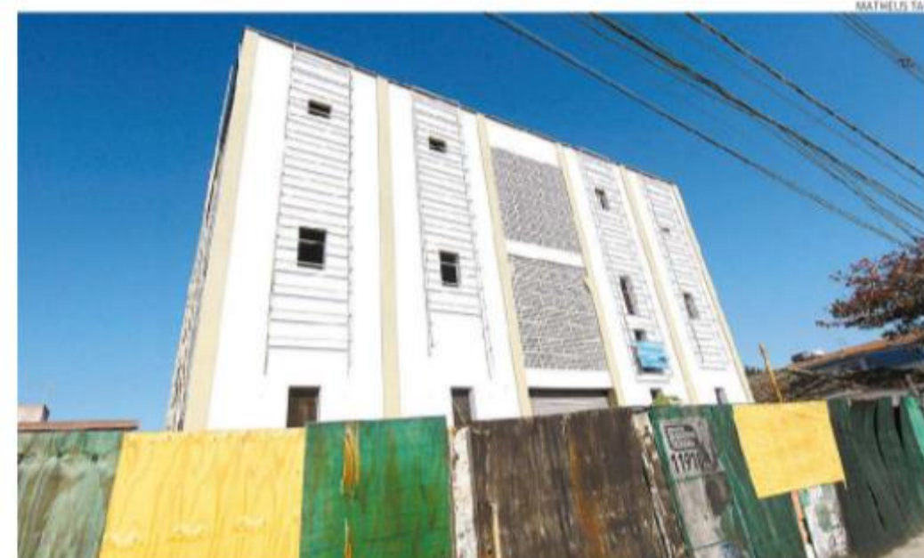
Prédio na Rua Bernardo Browne, 122/124, no Estuário: local deverá substituir sede do Saboó, desativada
