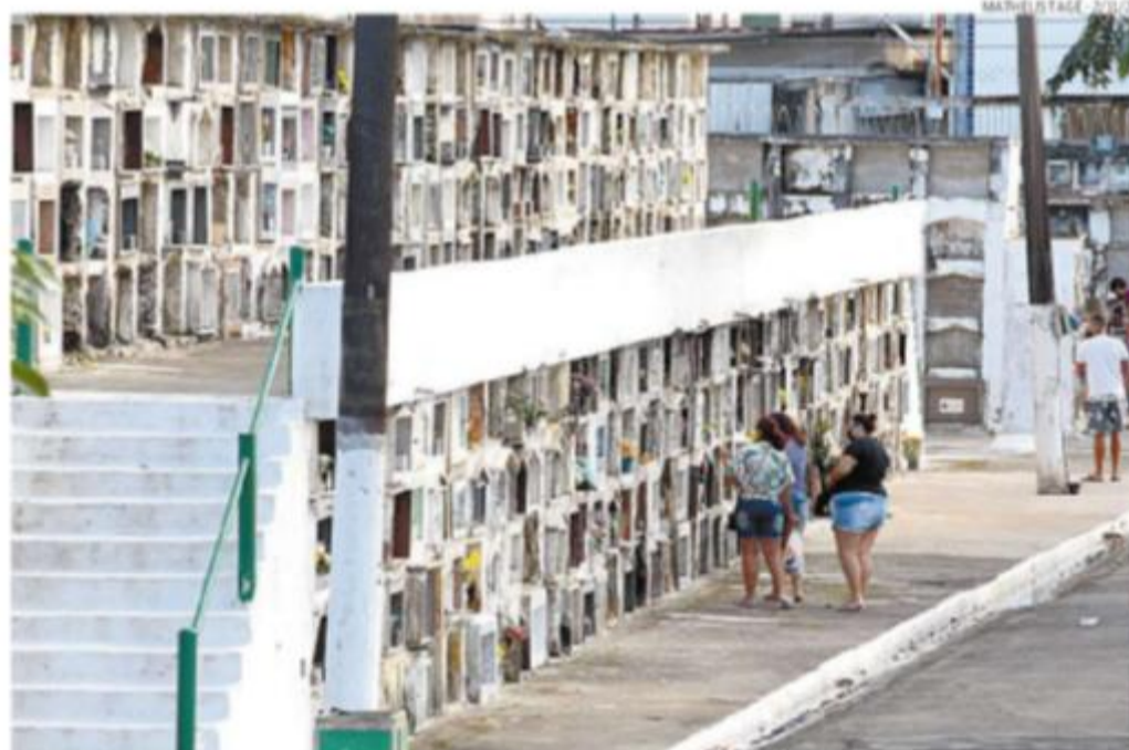
Houve reforço de espaço com a construção de um jazigo com 560 campas no Cemitério da Areia Branca
