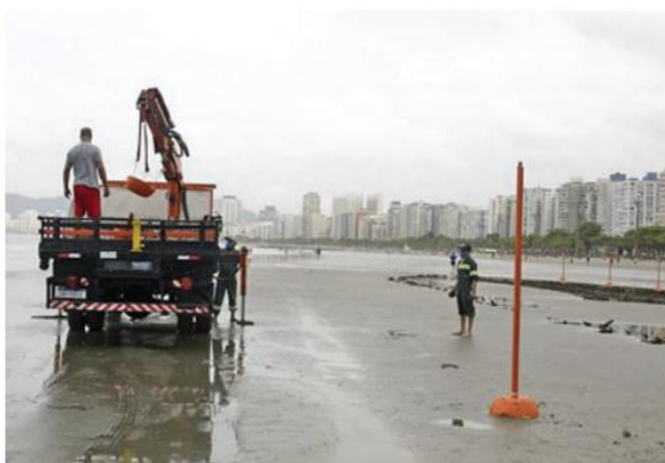
A área isolada na praia de Santos terá aproximadamente 22m de largura e 72m de comprimento
