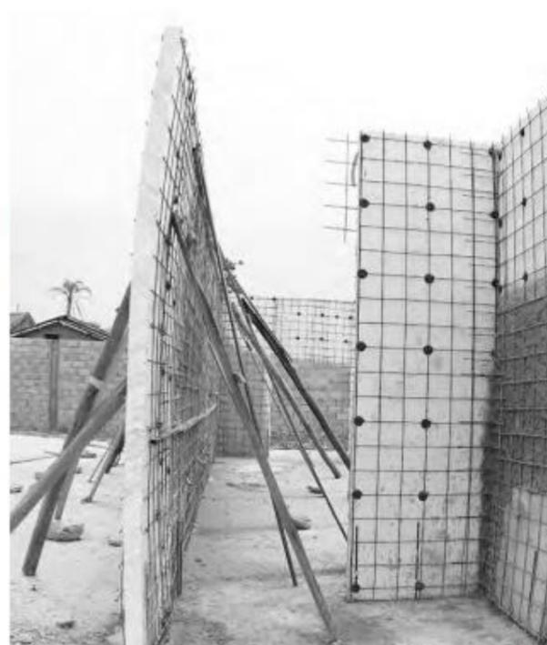
Casas são construídas com painéis monolíticos e feitas no sistema de radier, de 15 cm, com uma camada dupla de malhas trilicicas
