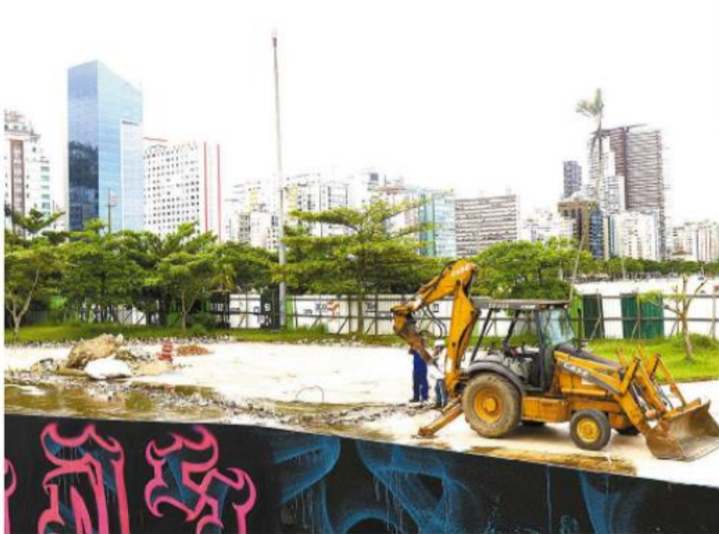
Todo o piso do parque será destruído, para que sejam feitos trabalhos de drenagem, hidráulicos e elétricos
