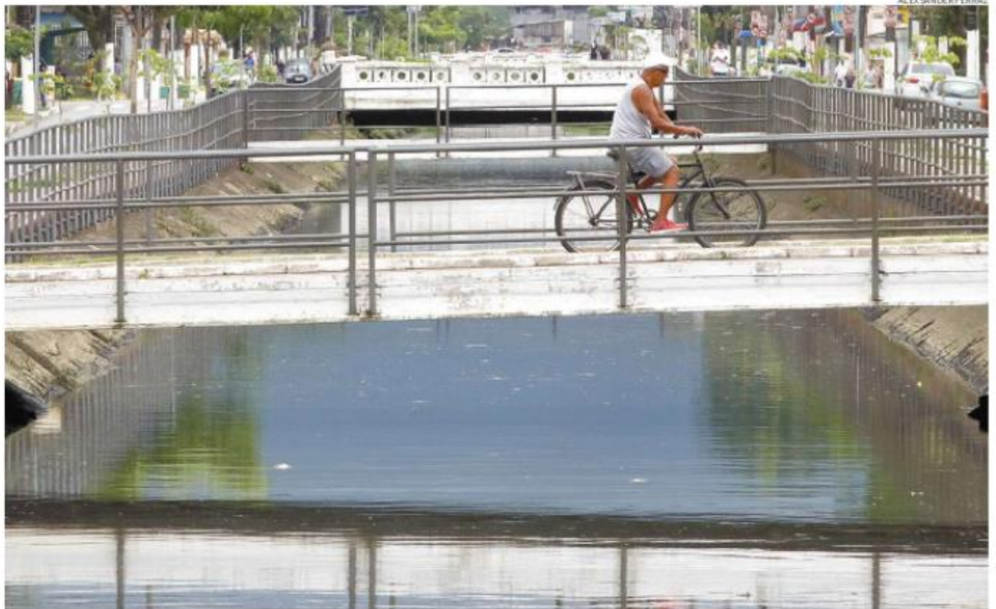
Objetivo é aperfeiçoar o programa Santos Novos Tempos, que inclui a realização das obras de macrodrenagem na Zona Noroeste de Santos
