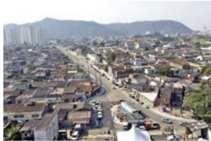
Ao todo serão investidos R$ 140.077.666,70 em diversas obras
