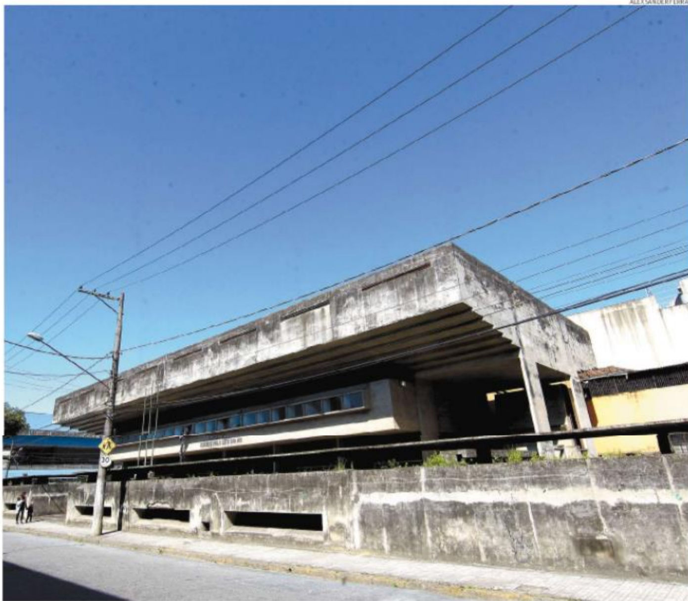
A Escola Acácio de Paula Leite deve receber a futura Escola do Legislativo e Cidadania: caminho será o da licitação para realizar as obras
