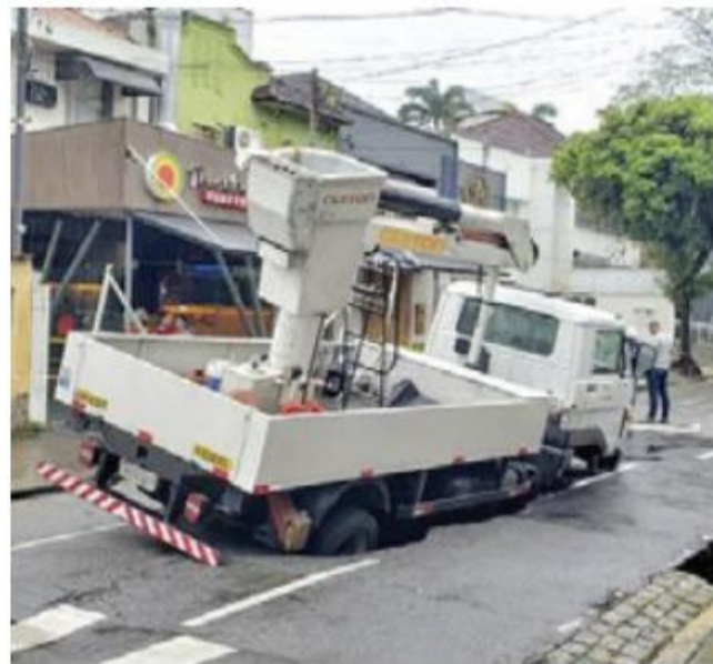
As equipes da empresa contratada já estão mobilizadas e dão andamento aos serviços programados para durarem 120 dias
