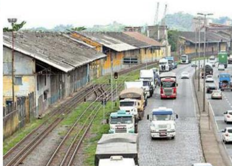
Investimentos separarão os cruzamentos rodoferroviários e garantirão fluidez ao escoamento por trens
