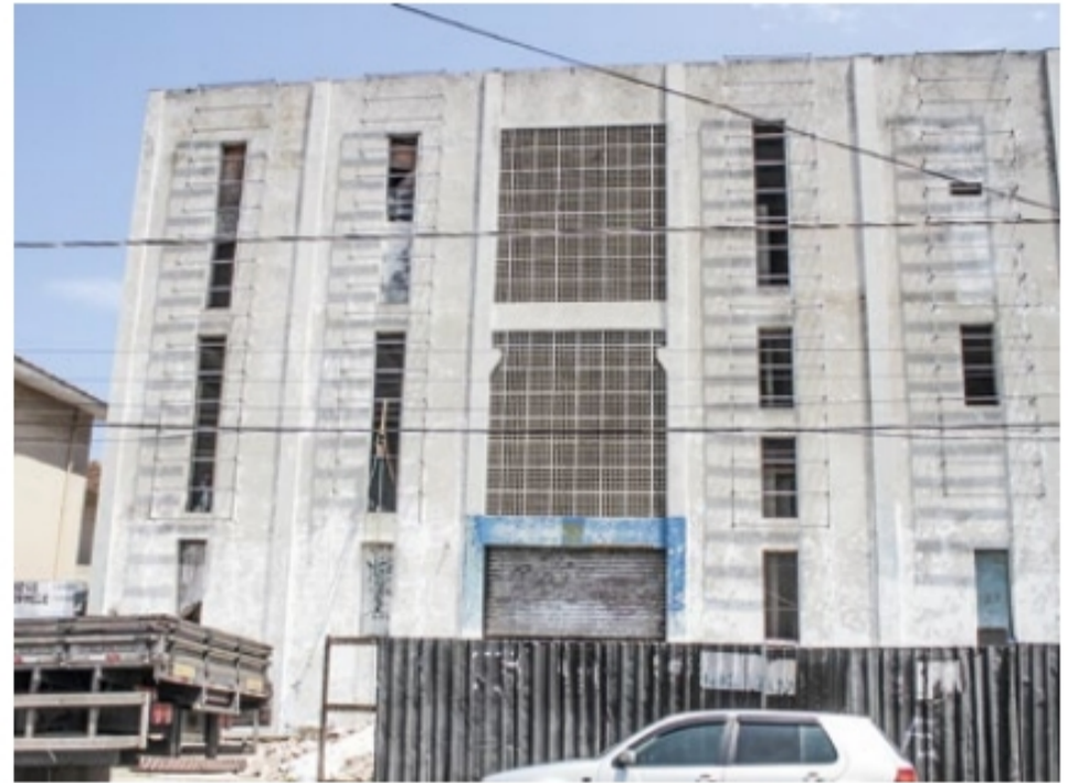
Moradores não querem que IML ocupe prédio da Bernardo Browne, no Estuário, em Santos
