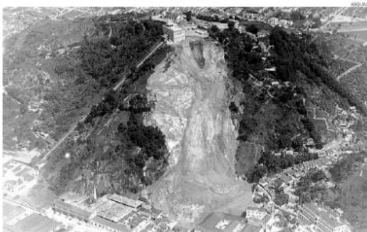
O desmoronamento parcial do Monte Serrat, em Santos, em 10 de março de 1928, matou pelo menos 81
