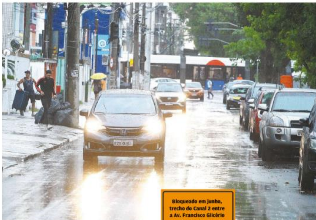
Pavimento da Rua Goiás está sendo recuperado nos locais onde ocorreram serviços
