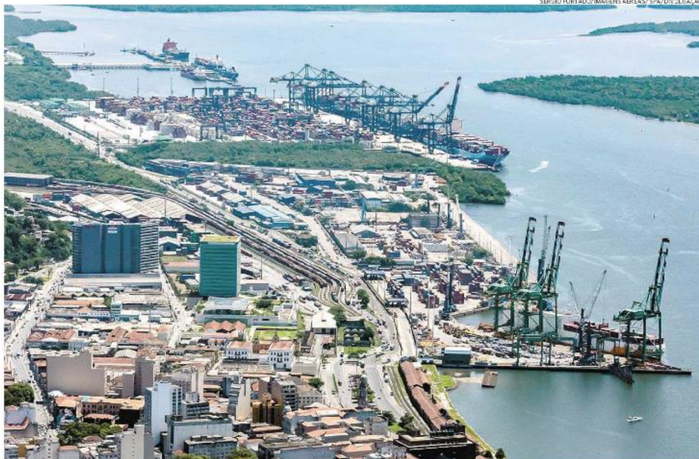
Localizado no cais do Saboó, o STS10 é visto como principal terminal a ser leiloado no porto santista, com área total de 601.101 metros quadrados
