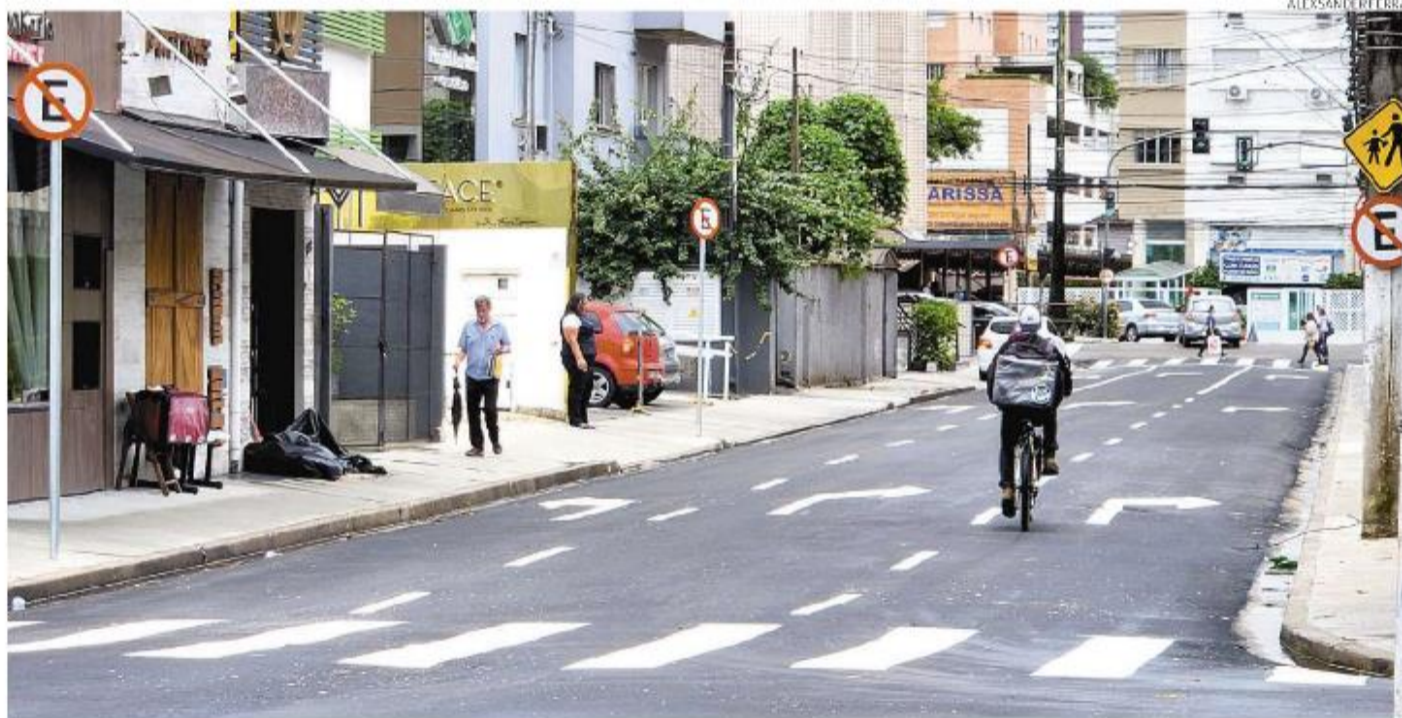
Obras na R. Goiás, entre Canal 3 e Av. Ana Costa, custaram cerca de R$ 15 milhões. Foram 450 metros de tubulação inseridos na rede de esgoto
