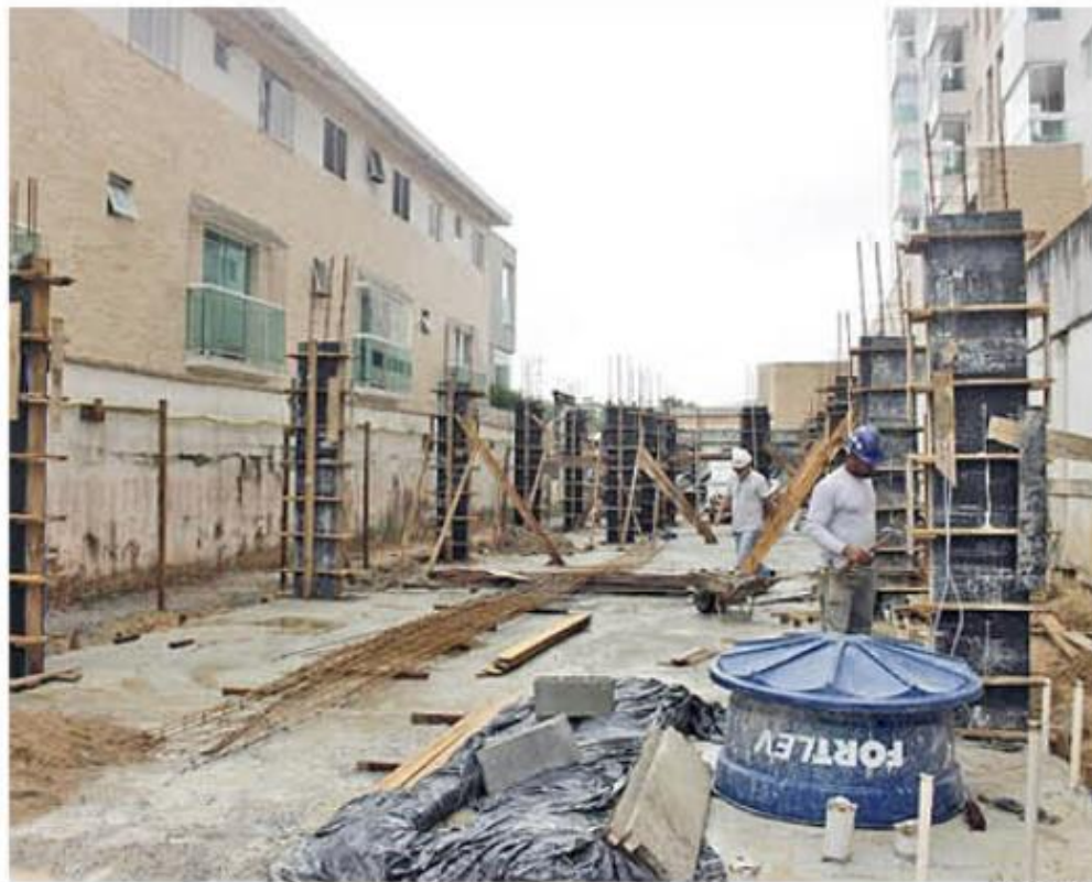
Uma nova e moderna unidade de saúde está sendo construída no terreno da Avenida Afonso Pena
