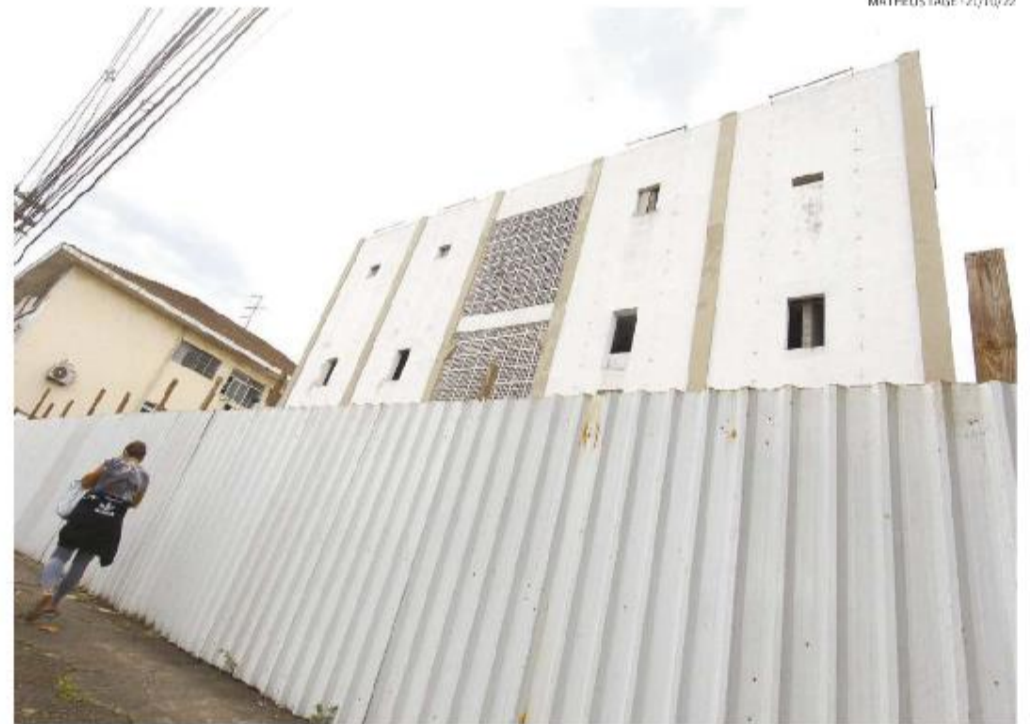
Está em construção uma nova sede para o Instituto Médico Legal (IML) em Santos, que fica no Estuário
