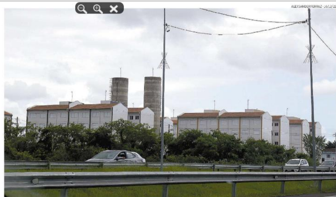
Projeto do Conjunto Habitacional Tancredo Neves 3 é de 2007. Serão 1.120 unidades, com investimento de R$ 140 milhões em verba federal
