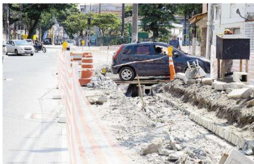
Luís de Camões é uma das vias onde obras estão ocorrendo e provocando reclamações
