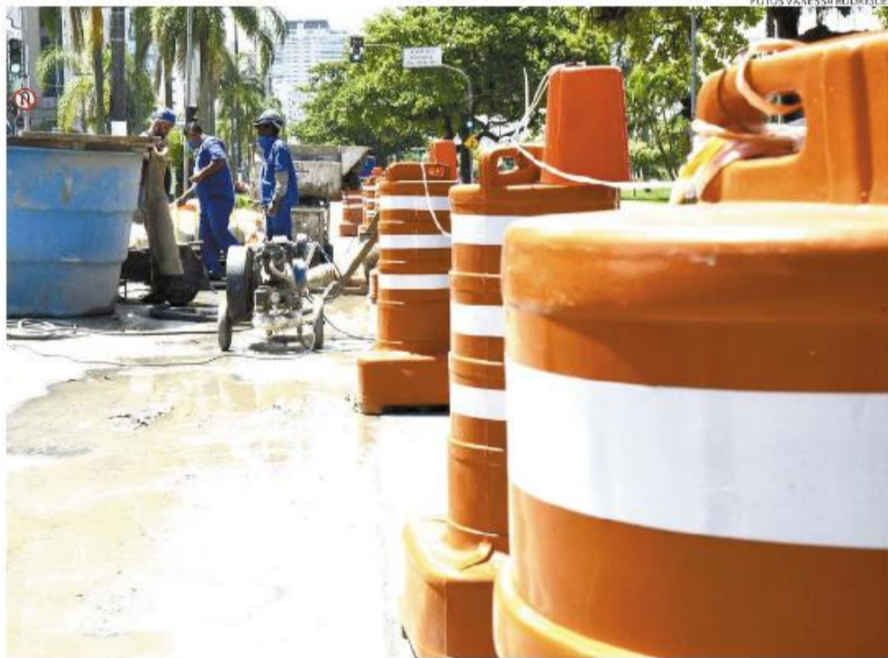
Tráfego está limitado por causa dos serviços no cruzamento da Pinheiro Machado com a Presidente Wilson
