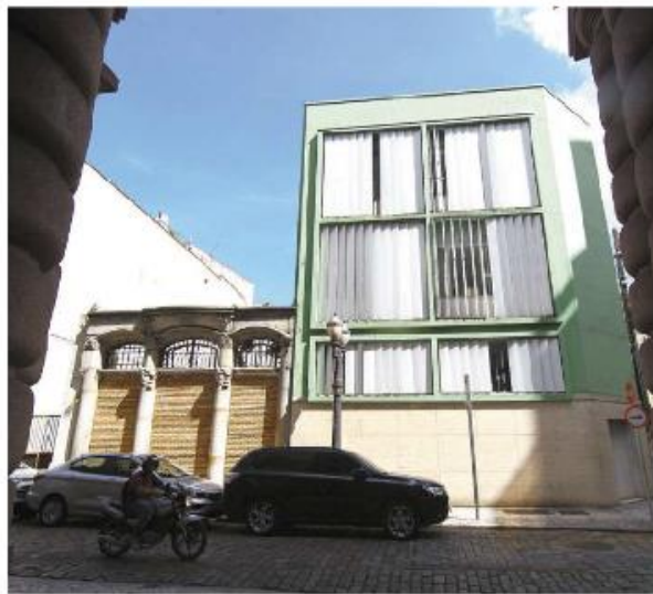
“Obra piloto” terá extensão de uma quadra, conforme a Prefeitura
