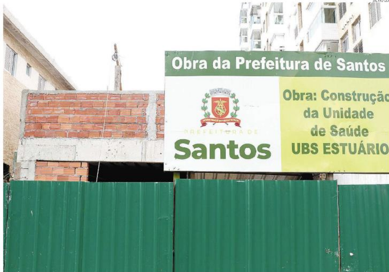
Em construção desde o ano passado, a futura Policlínica do Estuário está sendo erguida na Avenida Afonso Pena, próximo à UPA Zona Leste
