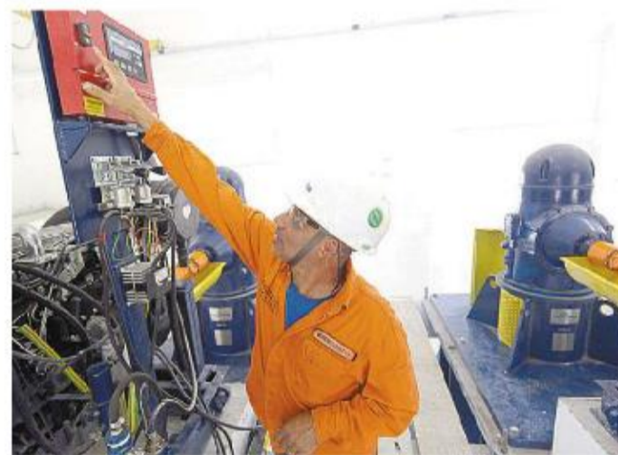
Custo é de R$ 38 milhões. Bombas podem ser acionadas a distância
