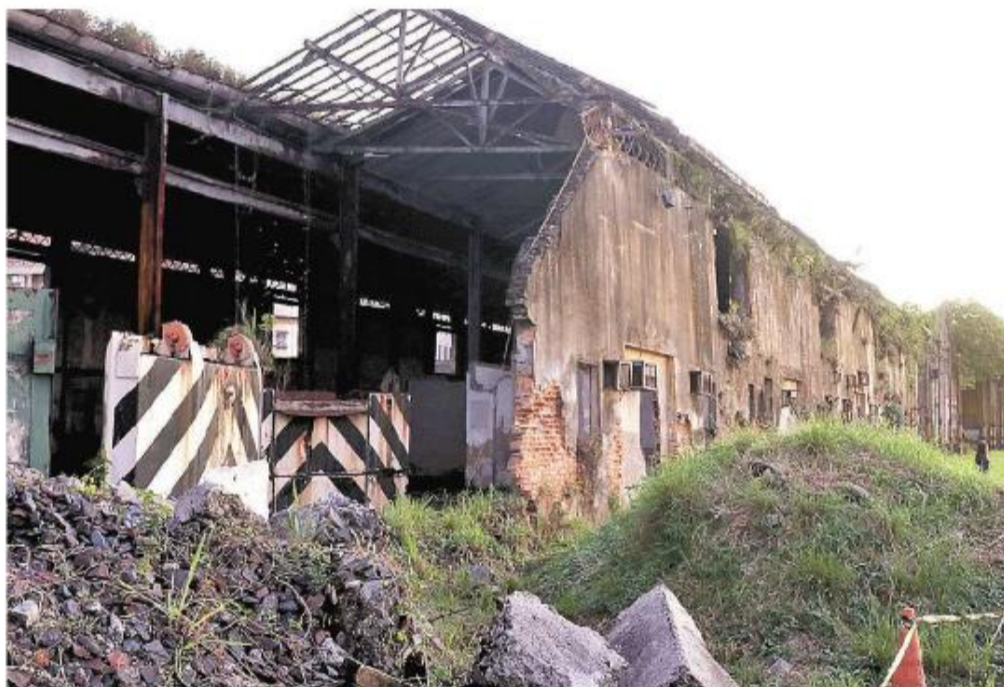
Governo Federal trabalha para que os armazéns 1, 2 e 3 possam abrigar um novo Terminal de Passageiros
