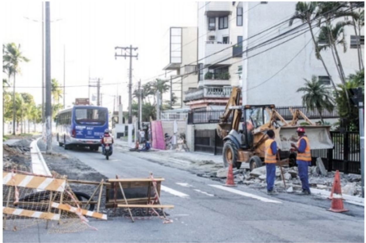
Parecer mostrou a fragilidade do EIV da Prefeitura sobre o CAT e obras na Ponta da Praia, que preocupam moradores e comerciantes
